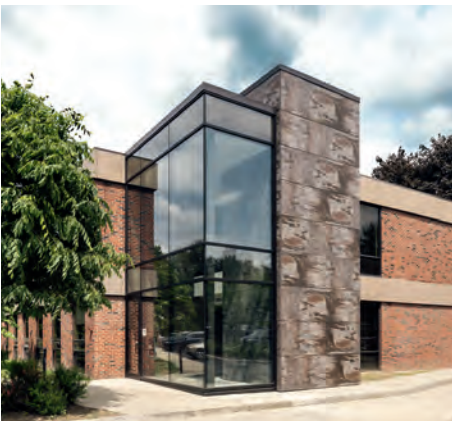
↑ Fasada wentylowana budynku w Armonk (USA) z wykorzystaniem Dekton Trilium.
