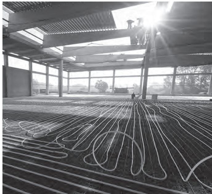
Aktywizacja termiczna betonowych płyt podłogowych.
