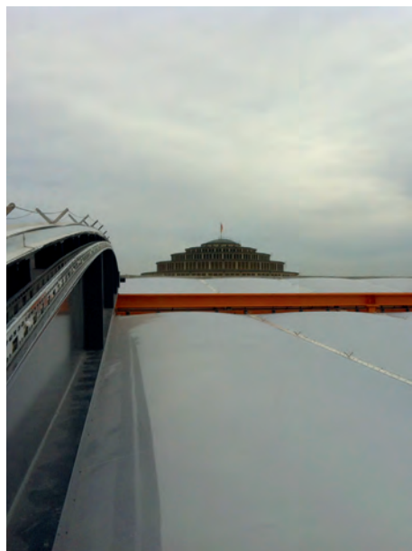
Fragment sklepienia wykonanego z ruchomych poduszek z ETFE, Afrykarium we Wrocławiu, widok na Halę Stulecia, proj. ArC2 Fabryka Projektowa.
