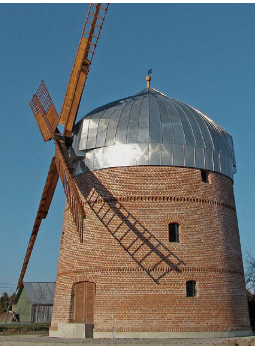
Murowany wiatrak typu wieżowego w Pyzdrach – jeden z nielicznych przykładów tego typu młyna wietrznego w Polsce, w którym zachowało się kompletne wyposażenie technologiczne.
