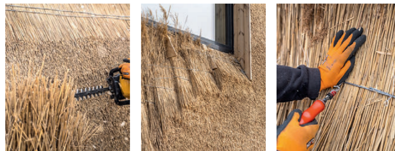
Końcowa faza wykonania słomianej fasady.
