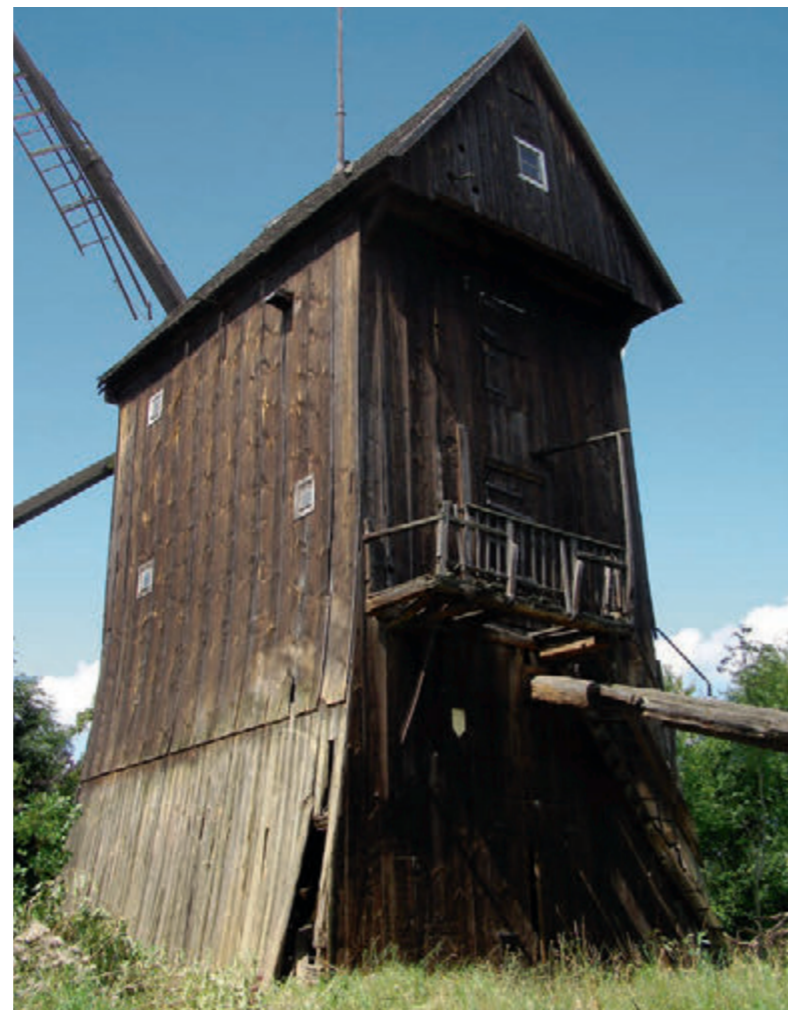
Wiatrak koźlak w Lesznie – przykład transformacji wiatraka na młyn elektryczny, ale z poszanowaniem i zachowaniem wszystkich atrybutów młyna wietrznego.
