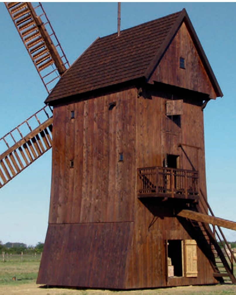
Wiatrak koźlak w Lesznie – przykład transformacji wiatraka na młyn elektryczny, ale z poszanowaniem i zachowaniem wszystkich atrybutów młyna wietrznego.
