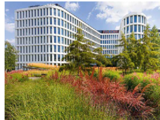
Wiśniowy Business Garden (Warszawa) – budynki i otoczenie tworzą razem „błękitno-zielony” park; proj. architektoniczny: JSK Architekci; proj. architektury krajobrazu: RS Architektura Krajobrazu (koordynator projektu zagospodarowania terenu).
